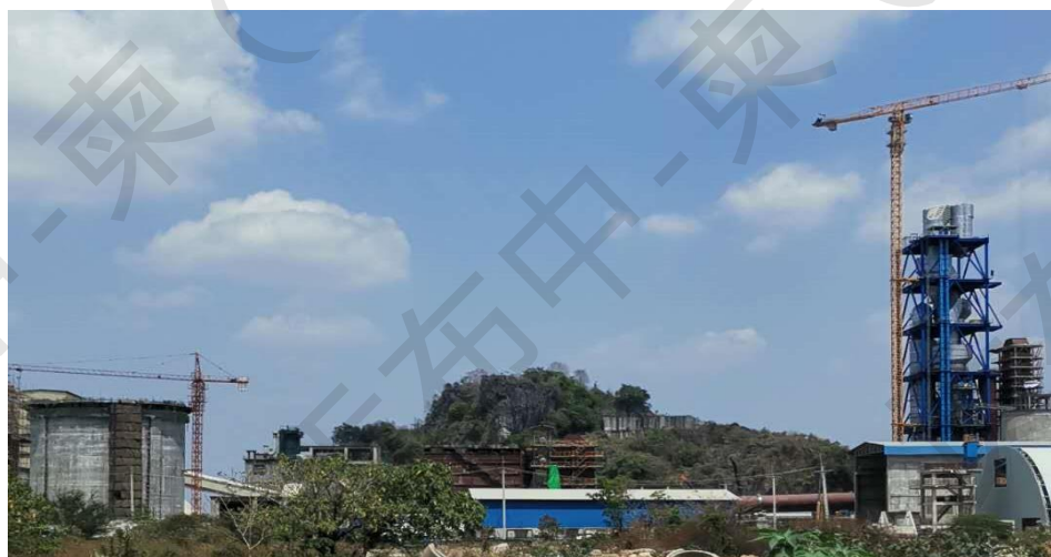
图 11 在建中的日产 3200 吨熟料水泥厂
