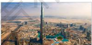
阿联酋迪拜大楼 Dubai Tower
