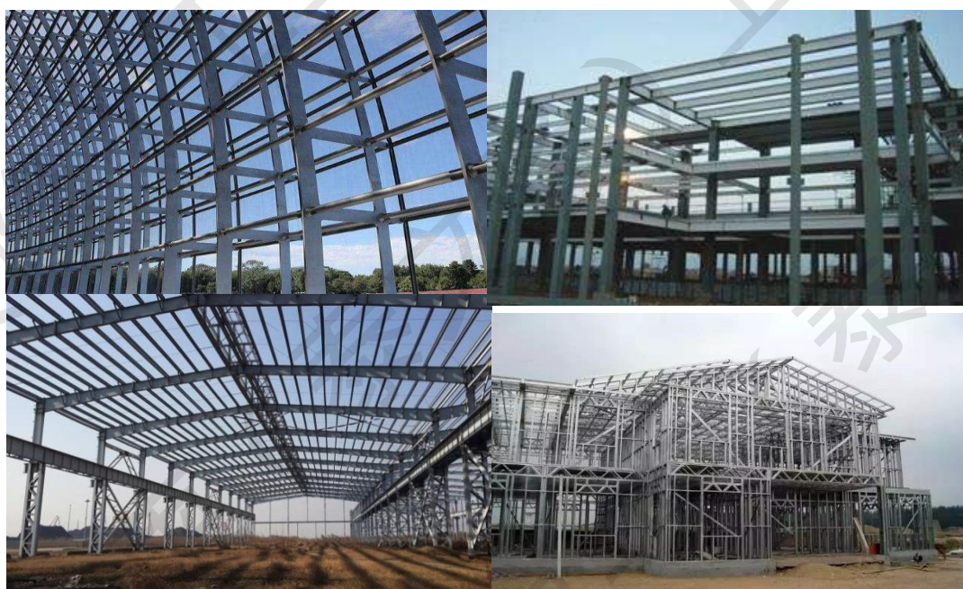
图 1-2 钢结构构件产品应用
