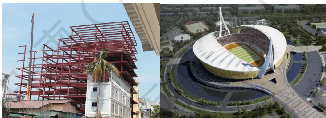
钢结构在建建筑（西哈努克） 柬埔寨钢结构国家体育场（金边，已封顶）
