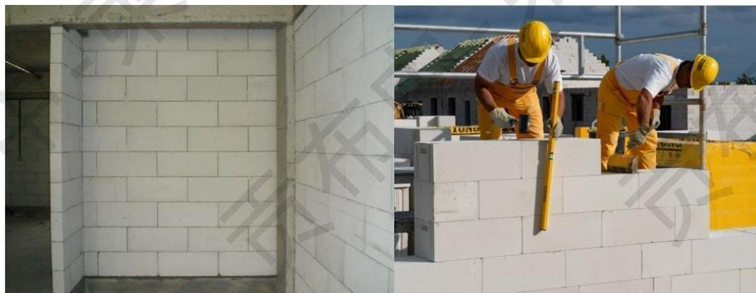
图 1-2 加气混凝土应用
